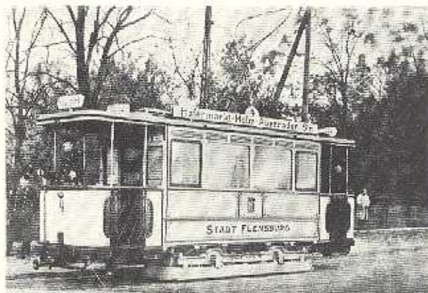
Abb. 1: Triebwagen 4 im Originalzustand 1907, Waggonfabrik Busch mit AEG-Ausrüstung; 16 Sitzplätze (Längsbänke), 19 Stehplätze, Länge: 7000 mm, Achsabstand: 1700 mm, Breite 1950 mm.
