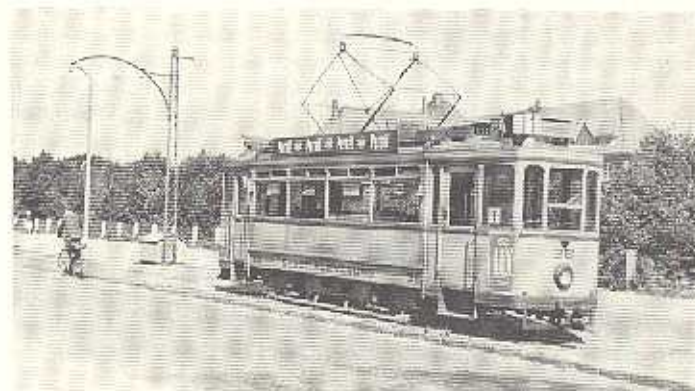
Abb. 7: Die Nachlieferung des gleichen Jahres (Tw 33–36) war lediglich durch verlängerte Plattformen (2000 mm statt 1700 mm) und dementsprechend größeren Wagenkastenlänge (10 000 mm) gekennzeichnet.
