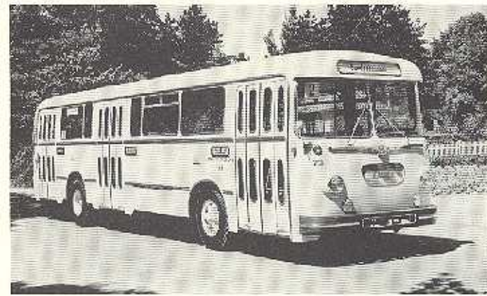
Abb. 18: Dreitüriger BÜSSING Unterflur-Trambus 23, ursprünglich für Fahrgastflub mit festem Schaffnerplatz aus der Lieferung September 1959.
