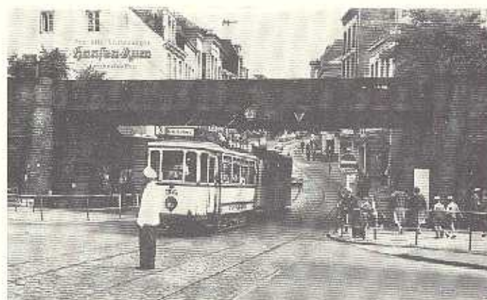
Abb. 11: Tw 34 + Bw 105 unter der Eisenbahnunterführung an der Kreuzung Angelburger Straße/Friedrich-Ebert-Straße/Süderhofenden.
